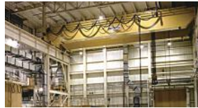
AREA LIGHTING 区域
